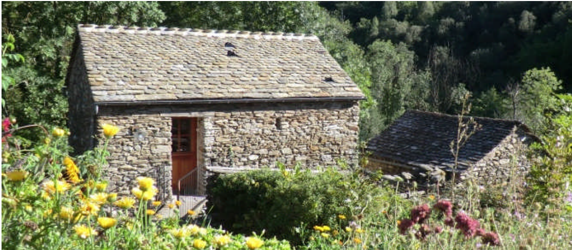
Die Brücke zum Eingang des „Chambre Haute“
